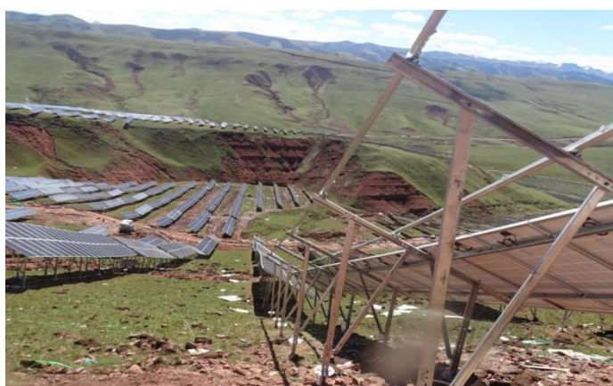
光伏区基桩施工（植被破坏极少）
