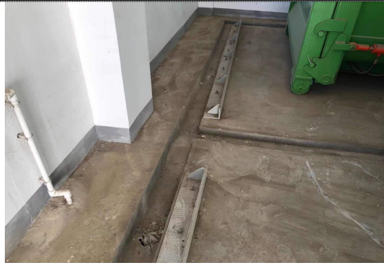
废水导流沟（压缩间内）
