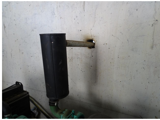
发电机废气排气口
